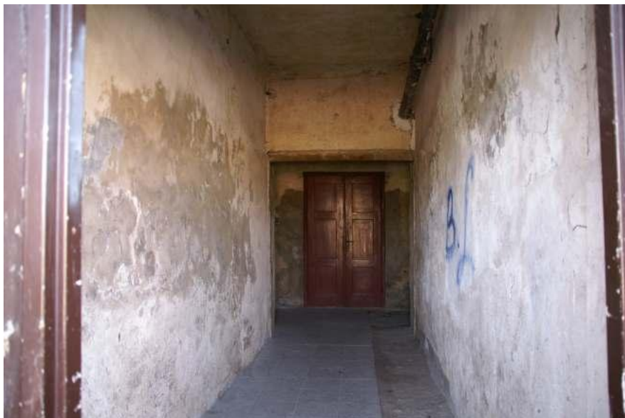
Fot. Klatka schodowa w kamienicy w centrum Krośniewic
