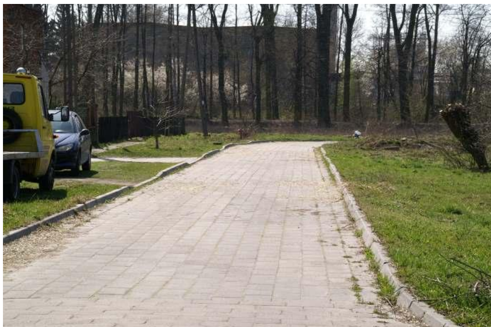
Fot. Południowo- wschodnia części miasta. Drogi są w bardzo złym stanie, brakuje również miejsc parkingowych i zagospodarowania terenu.
